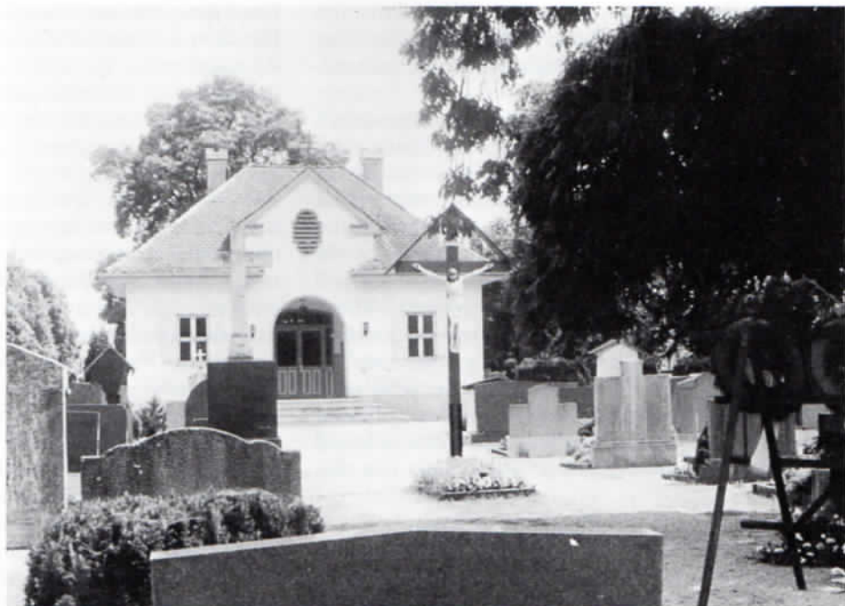
Das 1900 erbaute Leichenhaus im 1875 neu angelegten Friedhof in Olching, Jabmstraße.
