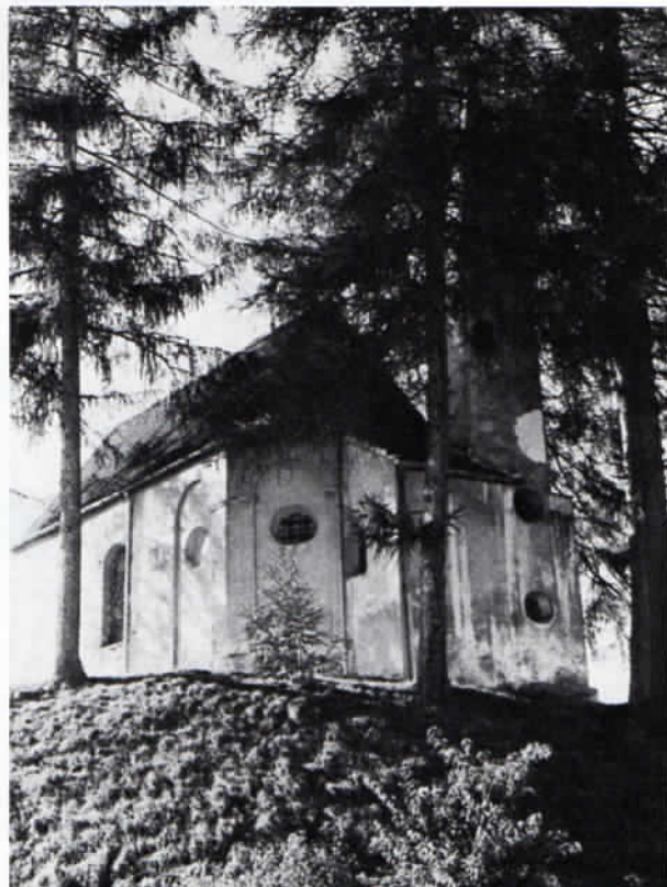
Die Altöttinger Kapelle in Althehnenberg mit ihrer auffälligen Lage auf einem künstlichen Hügel. Rechts am Bauwerk ist noch ein Teil des ehemaligen Achteckbaukörpers mit seiner Bogengliederung zu erkennen.
