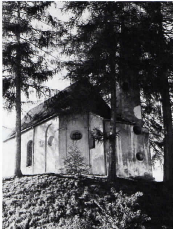
Die Altöttinger Kapelle in Althehnenberg mit ihrer auffälligen Lage auf einem künstlichen Hügel. Rechts am Bauwerk ist noch ein Teil des ehemaligen Achteckbaukörpers mit seiner Bogengliederung zu erkennen.
