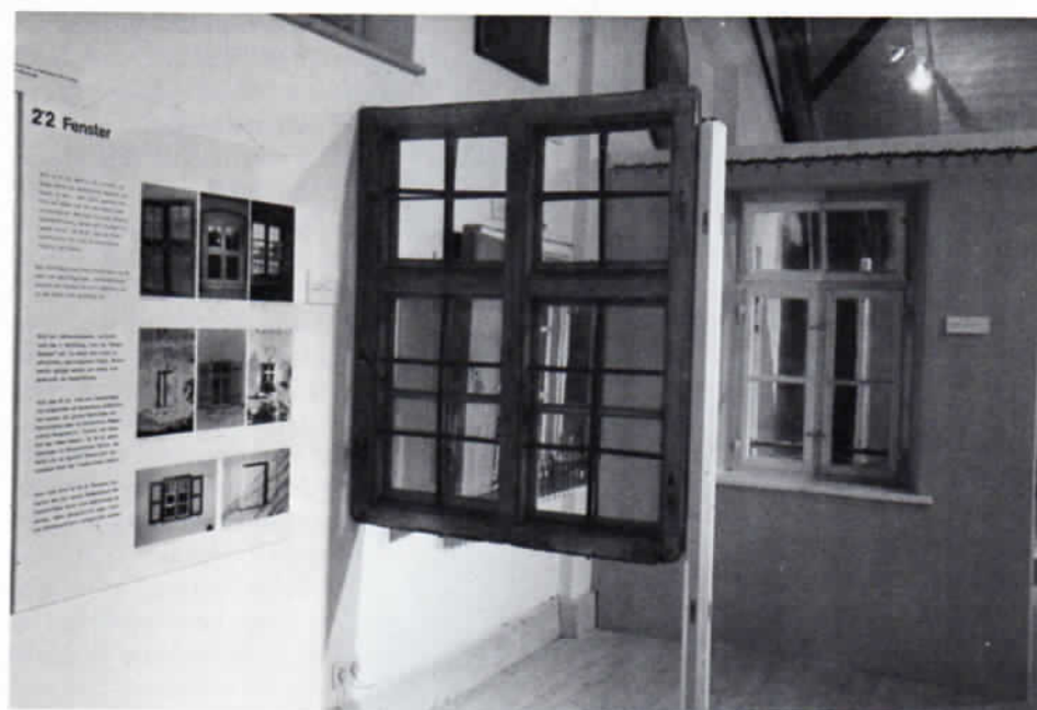
Barockes Kreuzstockfenster und »modernes Galgenfenster« mit Kippoberlicht aus den 20er Jahren. Foto: Alexander Zeh
