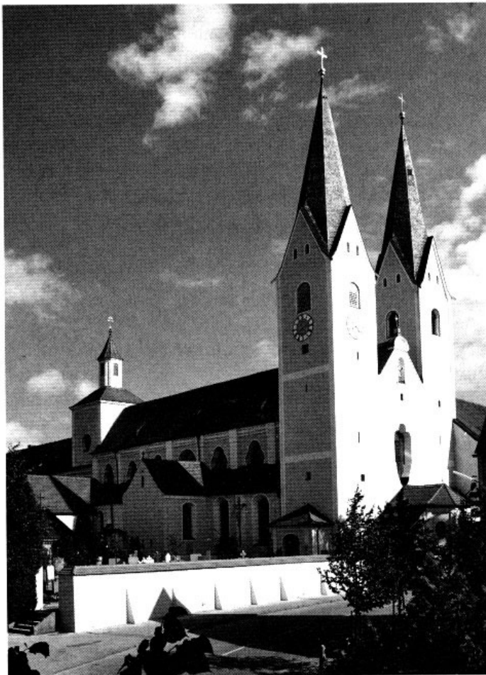
Pfarrkirche Kloster Indersdorf, Außenansicht nach Restaurierung von Kirche und Friedhofsmauer, August 1988.
