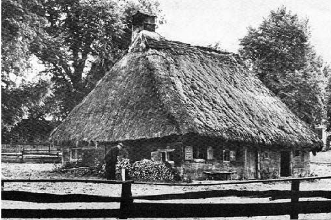
Söldenhäusl in Bergham bei Erding
