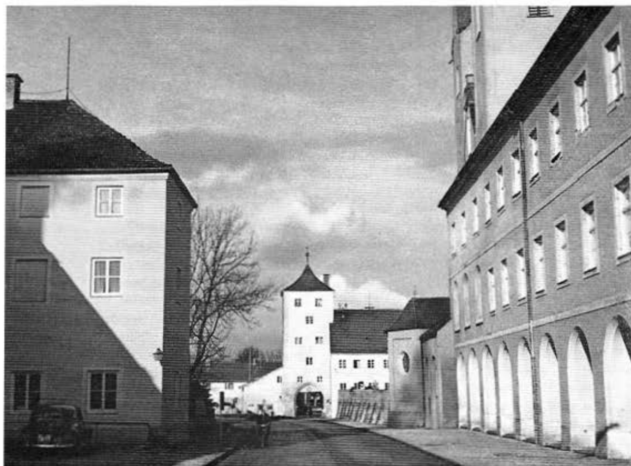
Neue Umgebungsstraße beim Indersdorfer Schneiderturm
