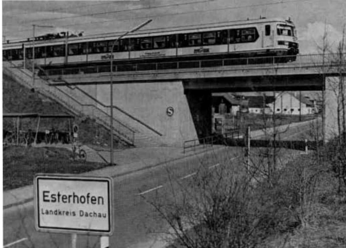
Unterführung Esterhofen mit S-Bahnstation.
