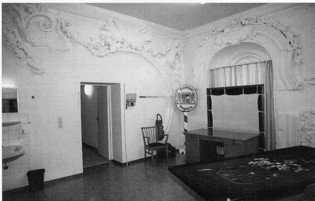
Abb. 3: Südostecke des ehemaligen Fürstensaales mit späteren baulichen Eingriffen und restauratorischer Suchleiste (rechts von Türe und Telefon), welche das Vorhandensein von freskaler Malerei zeigt.
