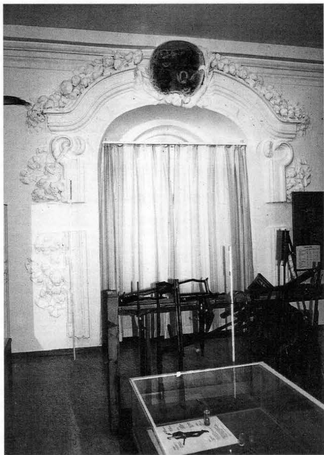
Abb. 4: Stuckumrahmung der mittleren Fensterachse des ehemaligen Fürstensaales.
