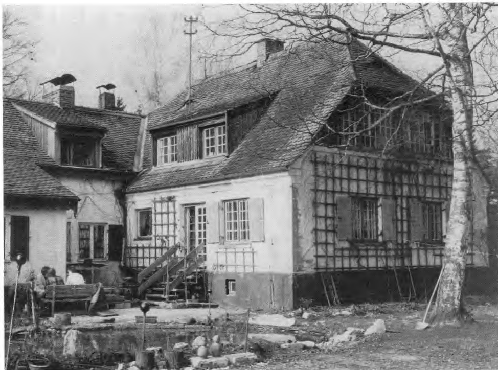
Das Plink-Haus in Eichenau in der 1911 von Richard Riemerschmid geschaffenen Form.
