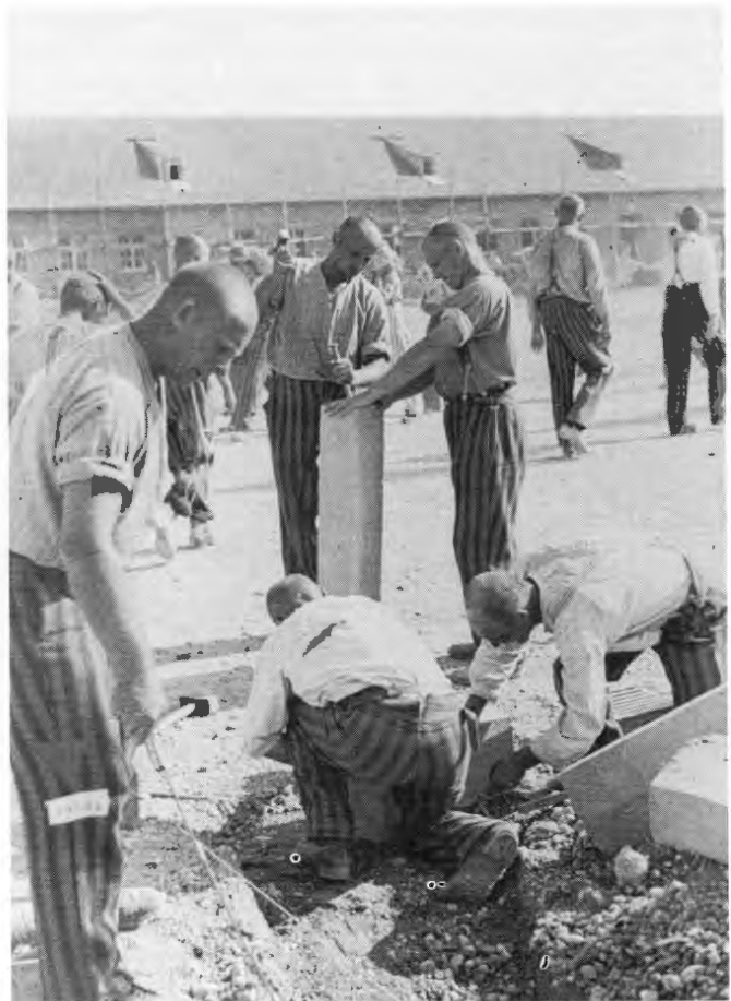
Dachauer Häftlinge bei Fundamentierungsarbeiten im neuen Schutzhaftlager.
