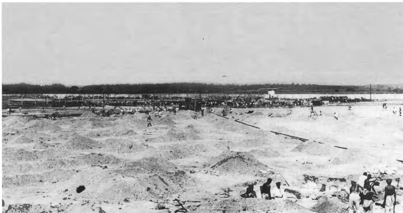
Das riesige Baugebiet, auf dem das neue Schutzhaftlager entstand. Dem Bauvorhaben musste der Fichtenwald, der dort stand, weichen.
