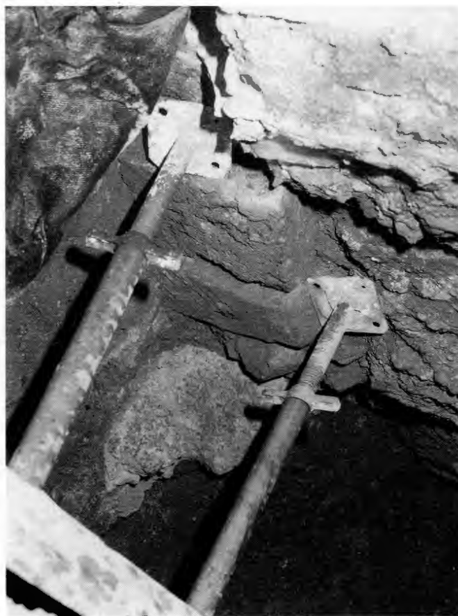
5 Altomünster, Sondage vor der Westfassade 2003. Romanisches Fundament eines Mauerstumpfs aus Werksteinen unter und neben dem Fundament des spätgotischen Fassadenpfilers, von Südwesten.
