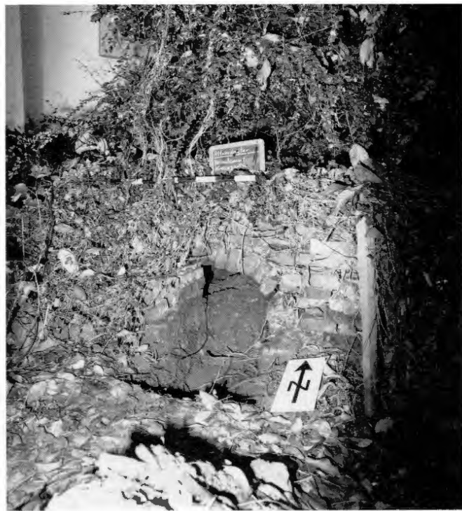
4 Altomünster, Sondage im Kreuzgarten des ehemaligen Herrenkonvents östlich des Oktogons 2000. Terrassenmauer mit integriertem Schlupfkeller, von Süden.
