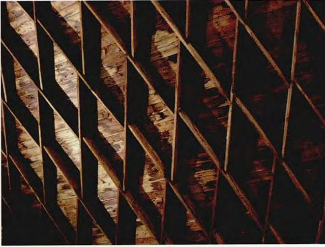
Marthabräuhalle mit Lamellendachkonstruktion
