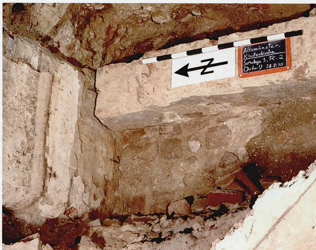
Grabung in der Sondage S3 mit einem freigelegten romanischen Pfeilerstumpf, Aufnahme vom 28. August 1995 Foto: Dr. Tilman Mittelstraß, Regensburg
