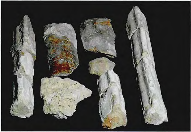
Formziegelsteinfragmente spätgotischer Gewölberippen in der Sondage S7 von 1995 Foto: Dr. Tilman Mittelstraß, Regensburg
