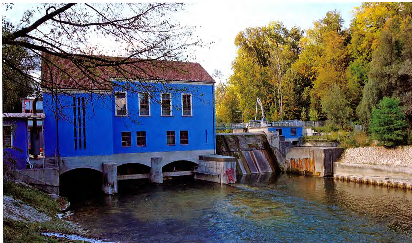
Wasserkraftwerk an der Amper links (WKW I) und Amper-Mühlbach-Kraftwerk rechts (AMKW)
