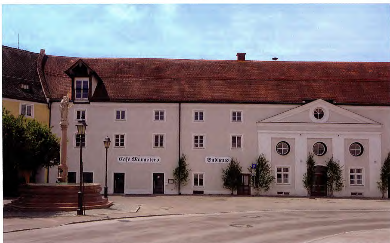
Blick auf den Bräuhaustrakt der Ökonomie, erbaut 1779/1780 mit der Mariensäule und einem Brunnen.
