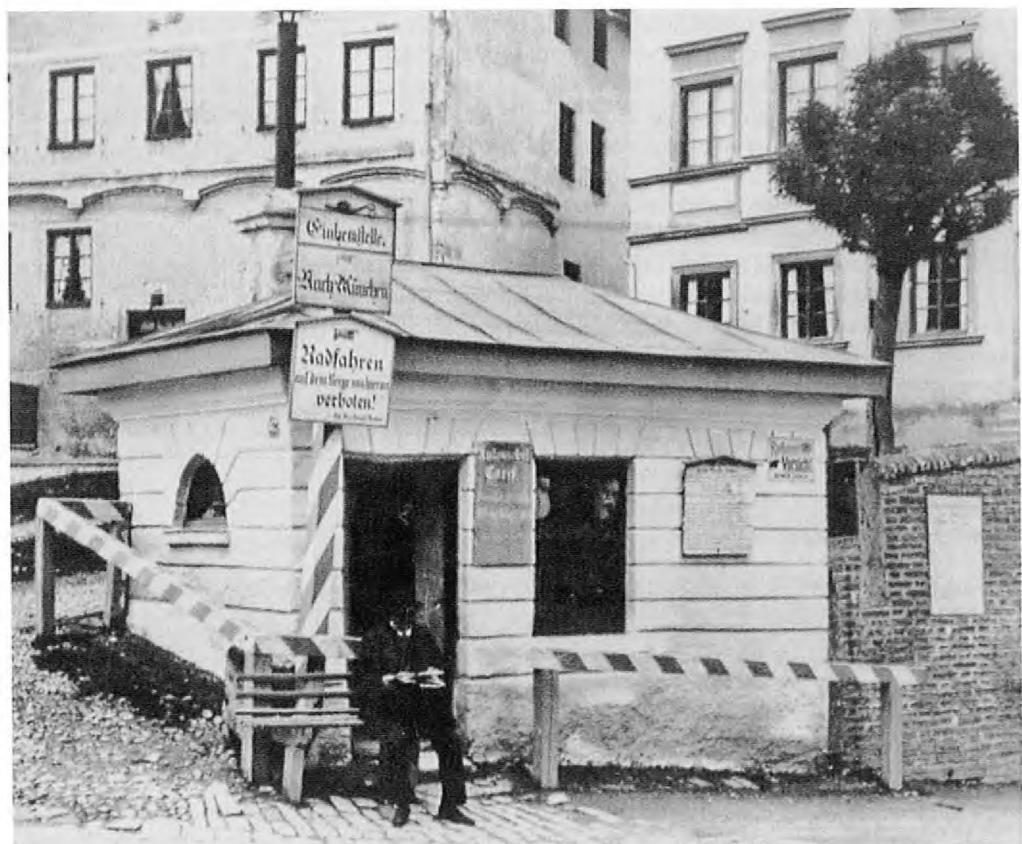
Abb. 4: Das alte Zollhäuschen und der Hinweis auf die Einheimmstelle, Foto um 1900
