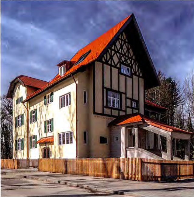
Abb. 2: Hölzel-Villa, aktuelle Aufnahme
